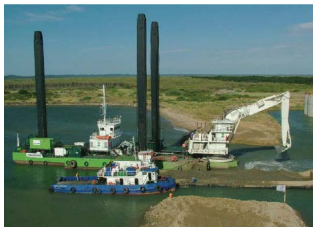
FIGUR 13.4: Eksempel på fartøj til udgravning af rende til tunnelelementer
