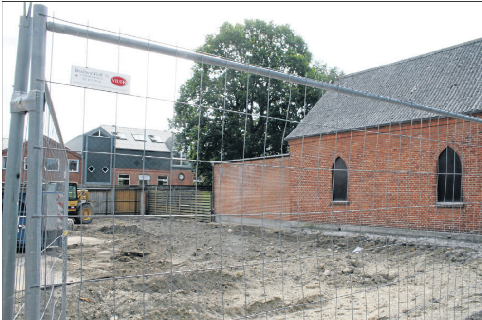
Grunden ved siden af Indre Missions Hus på Kocksvej 10 er ryddet og erstattes snart af en byggeplads. Foto: Maj-Britt Holm
